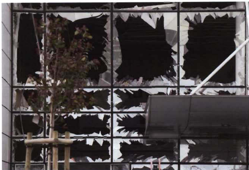
Figure 3.22 : Vitrage soufflé lors des attentats terroristes du 22 mars 2016 à Bruxelles en Belgique.
