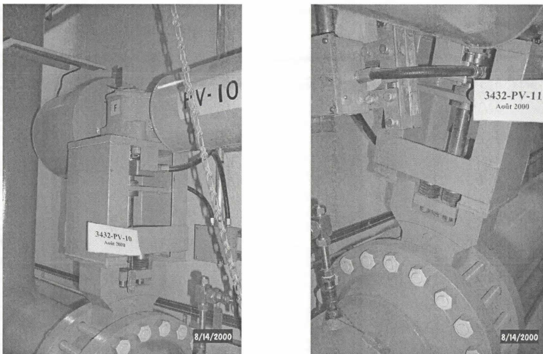
Figure C1 : Vannes 3432-PV10 et PV11 du système de refroidissement d'urgence du cœur
