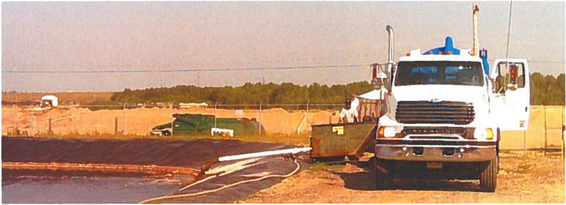
FIGURE 1.7 : Photo prise lors d'une vidange des boues de fosses septique dans l'étang d'accumulation.
