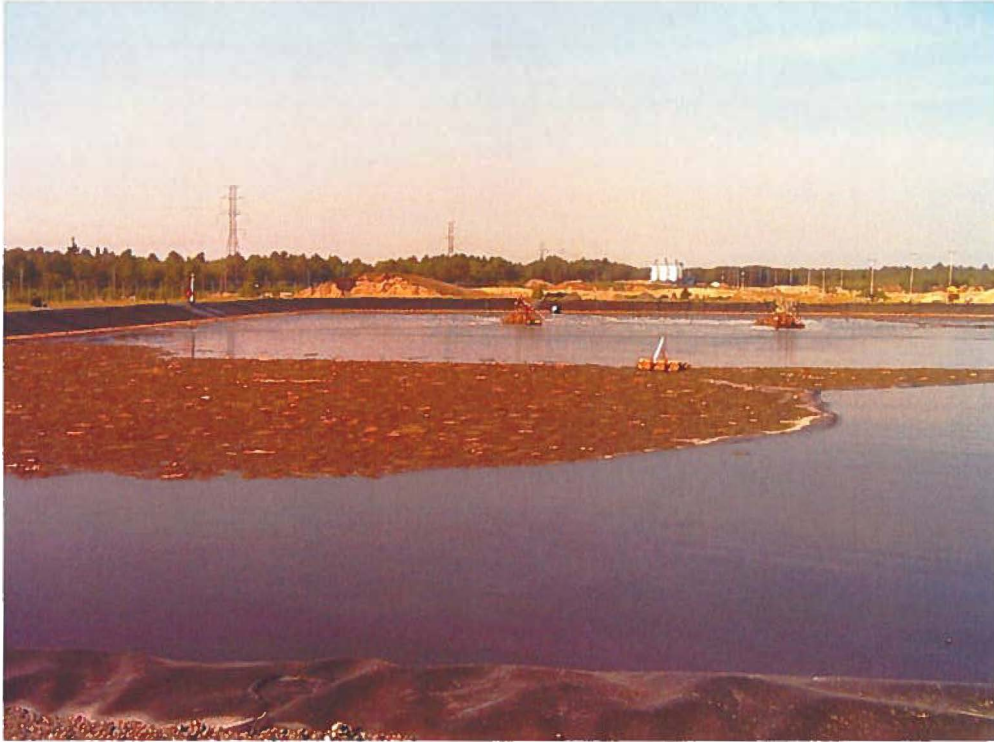
FIGURE 1.8 : Photo de l'étang d'accumulation. On observe les aérateurs flottants au dernier plan.
