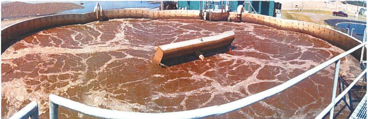
FIGURE 1.9 : Photo du Réacteur Biologique Séquentiel (RBS).
