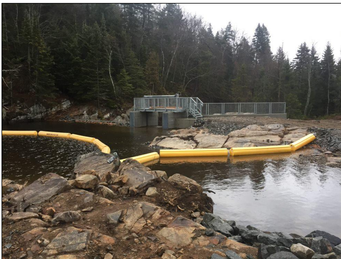
Figure 3.I Structure de contrôle du niveau d'eau du lac En Croix (MFFP, 2021).
