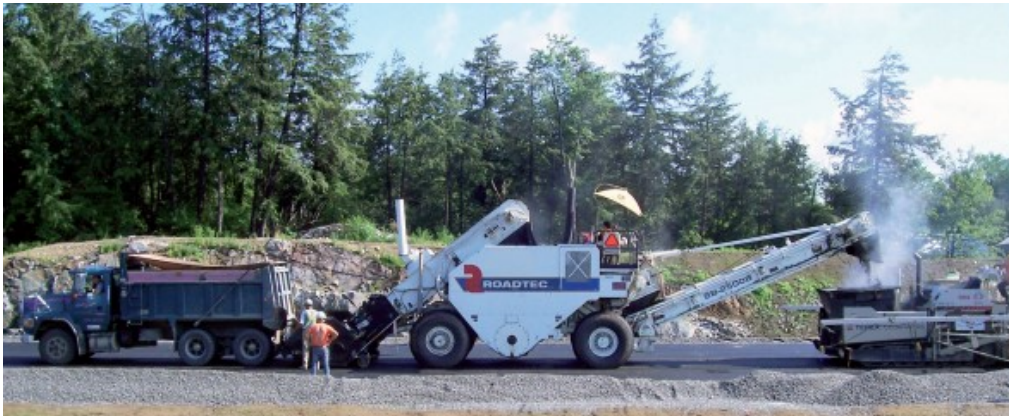
Figure 5 – Véhicule de transfert des matériaux (Ball, 2021).
