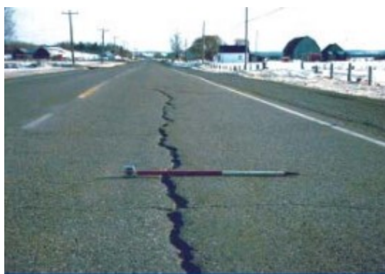
Figure 10 – Fissure en piste de roues (MTQ, 2011)
