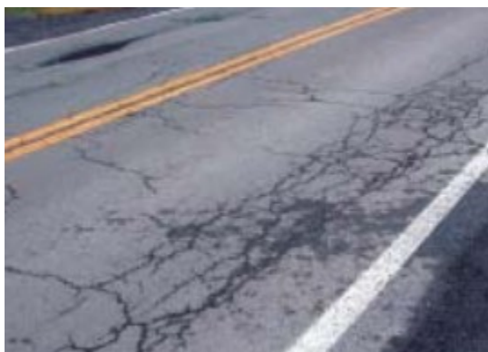
Figure 10 – Fissure en piste de roues (MTQ, 2011)
