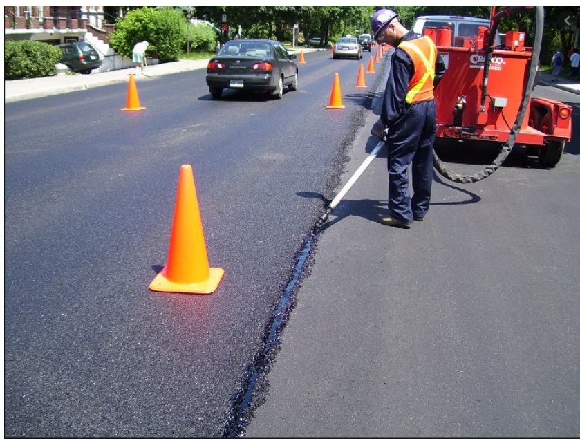
Figure 7 – Application d'un joint Crafcro (Fédération canadienne des municipalités, 2003).
