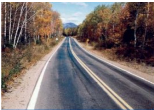
Figure 19 – Désenrobage et arrachement (MTQ, 2011)
