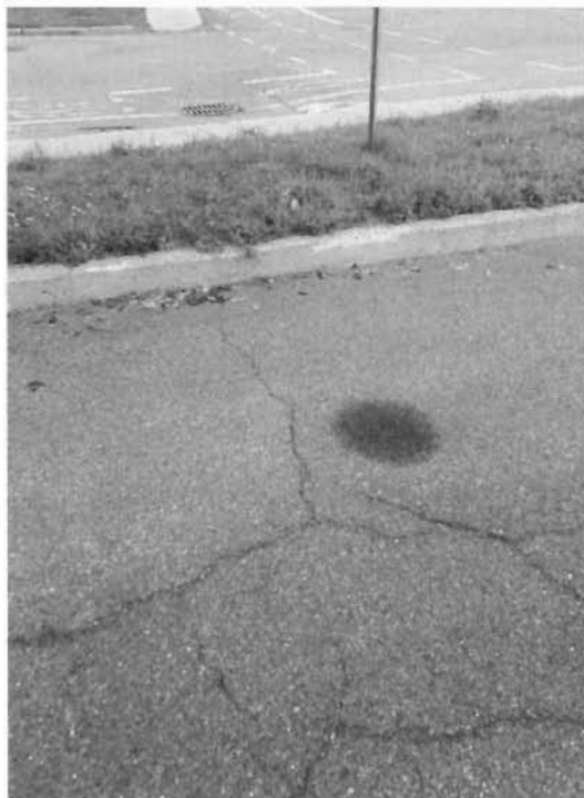
Photo 10. Muret de ciment et gazon
