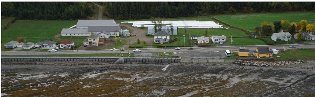
Figure 17. Mur et enrochement présent à l'ouest du quai de Sainte-Flavie en 2017 (Mention de source : Laboratoire de dynamique de gestion intégrée des zones côtières – UQAR, 2017)
