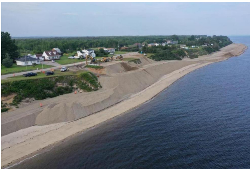
Figure 12. Plage de Pointe-aux-Outardes pendant les travaux de rechargement de plage (Mention de source : Ministère de la sécurité publique, 2021)
