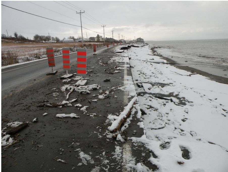
Figure 1. Affaissement de la route longeant le fleuve à Sainte-Flavie, dans le Bas-Saint-Laurent, causé par les vagues lors d'une tempête en 2010 (Mention de source : Laboratoire de dynamique de gestion intégrée des zones côtières – UQAR, s.d.)
