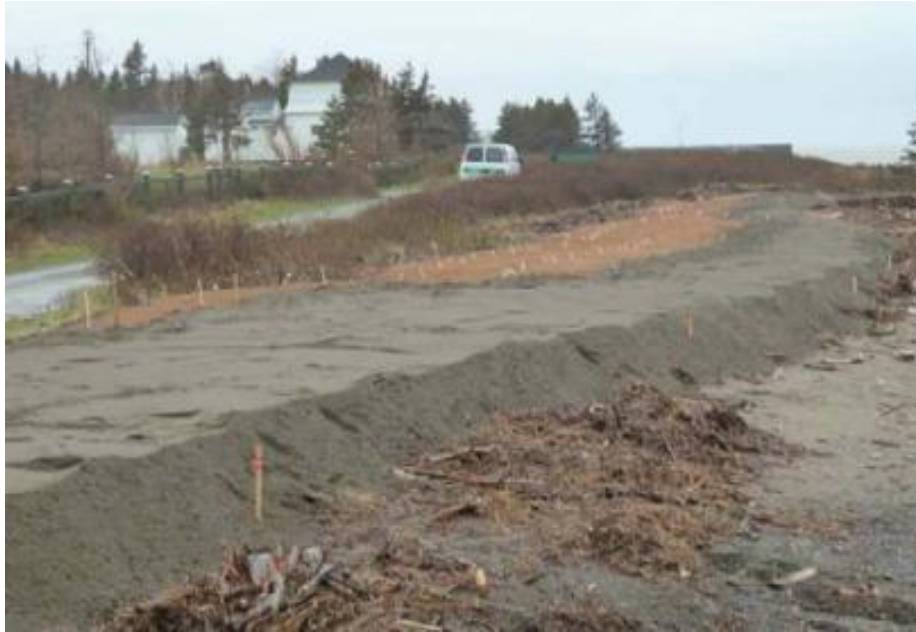
Figure 6. Recharge en sable et filet stabilisateur – Rivière-Ouelle (Mention de source : Étienne Bachand – Comité ZIP du Sud-de-l’Estuaire, 2013)
