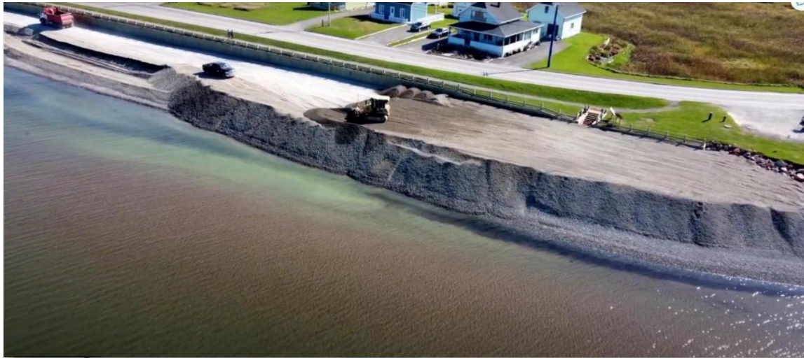
Figure 15. Site historique de La Grave pendant les travaux de rechargement de plage (Mention de source : Ministère de la sécurité publique, 2011)
