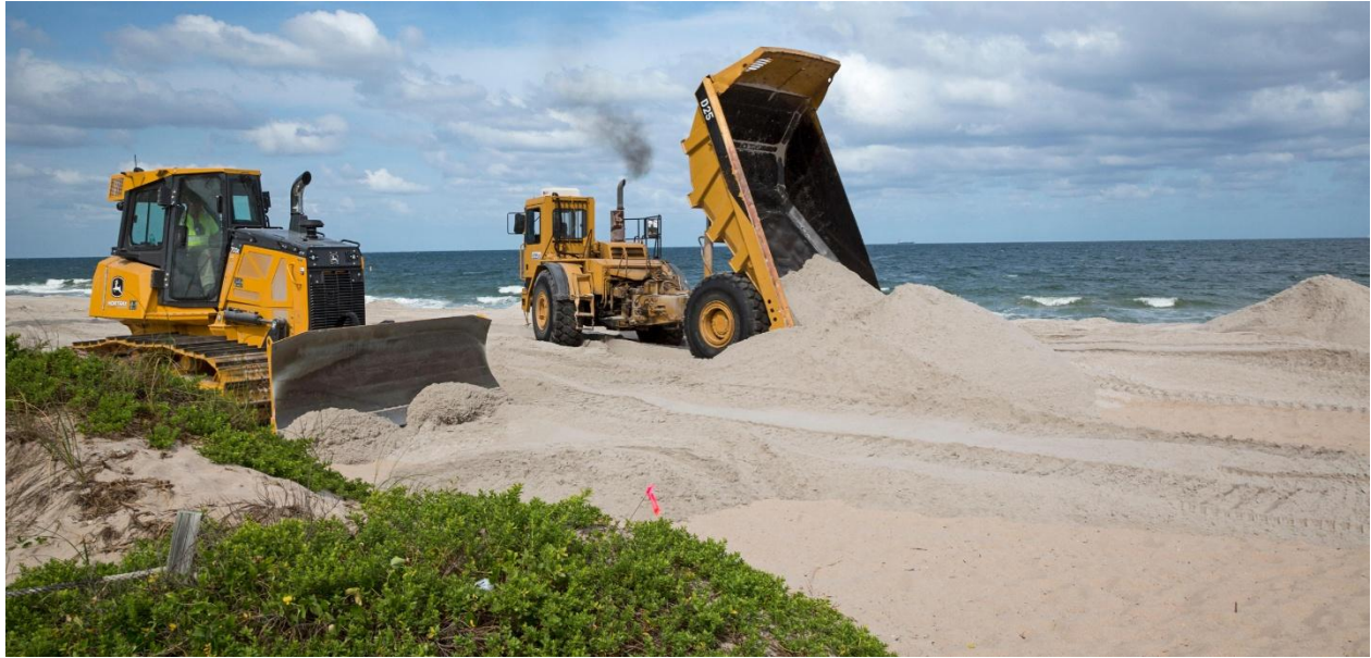
Figure 4. Rechargement de plage par camion à Fort Lauderdale, en Floride (Mention de source : Hakai Magazine - United States Army Corps of Engineers , 2016)
