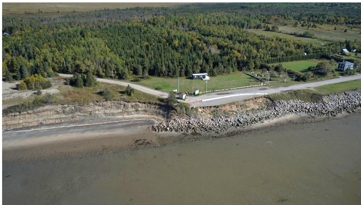
Figure 2. Effet de bout à l'extrémité d'un enrochement effectué à Pointe-aux-Outardes (Mention de source : Laboratoire de dynamique de gestion intégrée des zones côtières – UQAR, s.d.)
