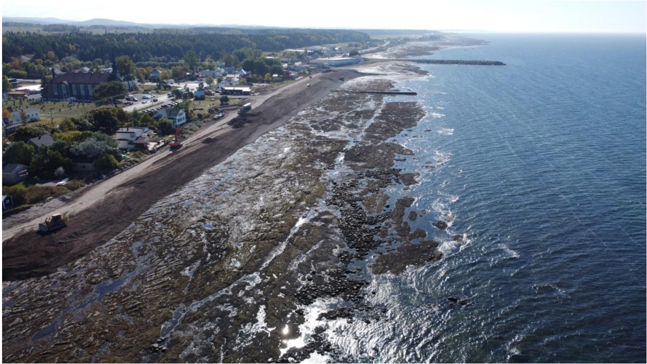
Figure 18. Travaux de recharge de plage à Sainte-Flavie (Mention de source : Ministère de la sécurité publique, 2024)
