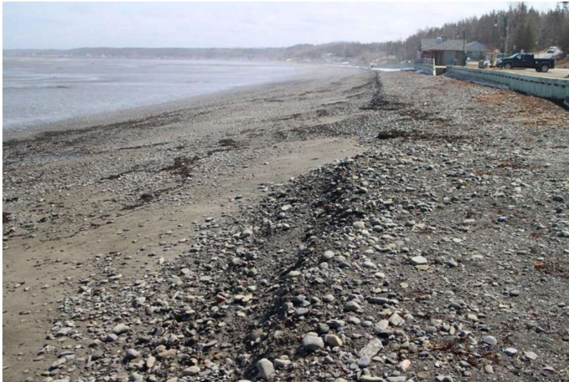
Figure 19. Recharge de plage de 2014 à Sainte-Luce, un an après sa construction (Mention de source : Municipalité de Sainte-Luce, 2015)
