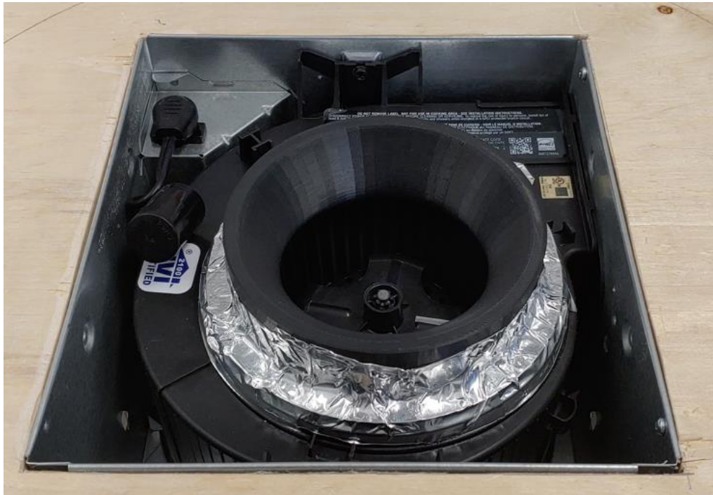
Figure 87: AE110 sans grille avec réducteur 4po
