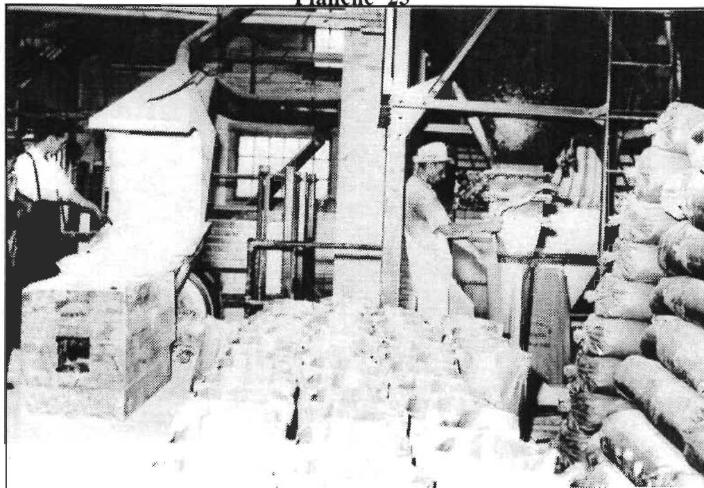
Empaquetage des pigments d'oxyde de zinc après leur traitement dans le four rotatif et le broyeur. ca 1940. Coll. privée, James A. Bradley.
