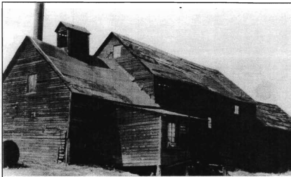
Bâtiment renfermant les bouilloires qui produisent la vapeur. ca 1935. Coll. privée, James A. Bradley
